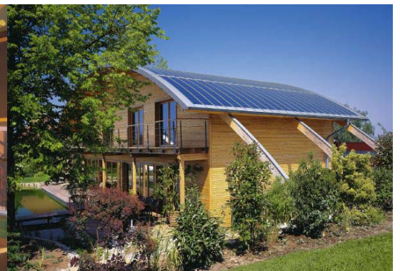
Solcellsintegrerat falsat plåttak, Rheinzink
